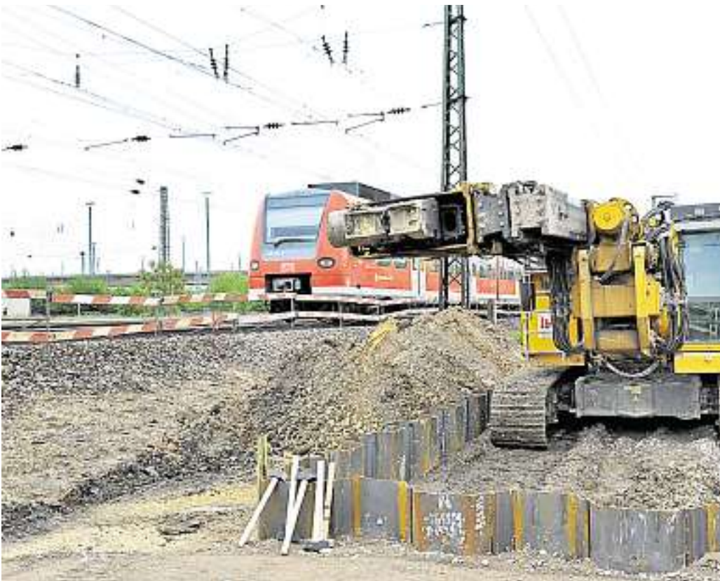
Fünf Jahre nach der Eröffnung der SAP-Arena wird nun auch der S-Bahn-Halt gebaut. Foto: AfP Asel
